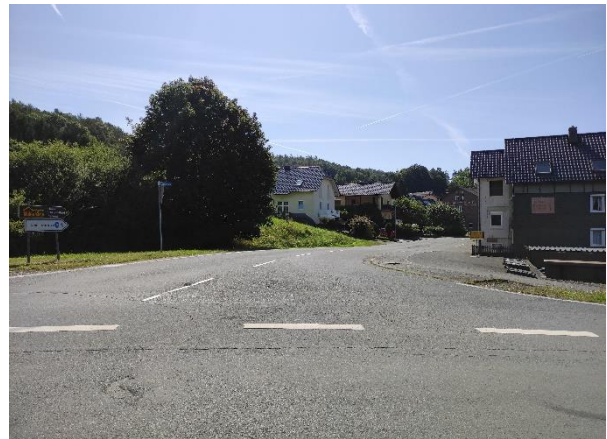
Abb. 6: Blick von K39 Eimündungsbereich
